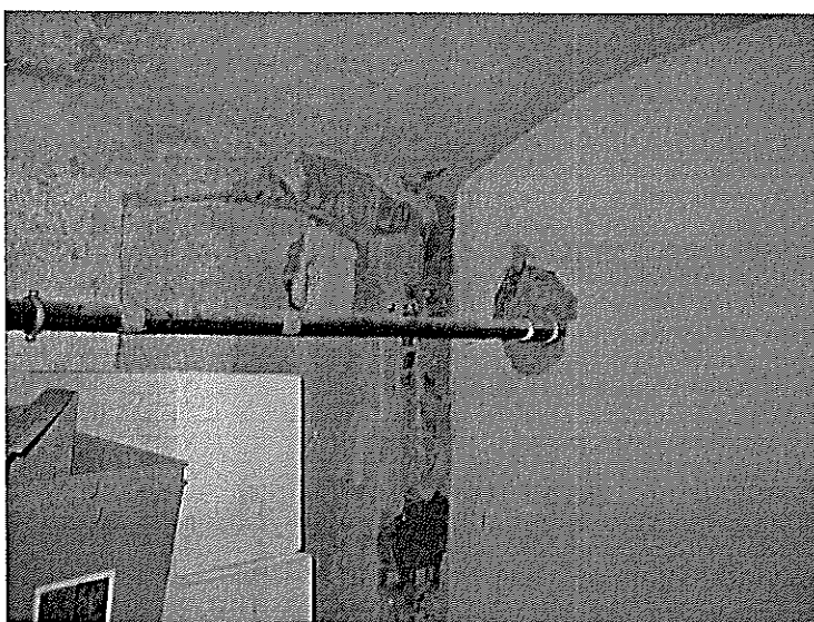
Vzorek č. 4 byl odebrán z vnitřní zdi pod hlavním severním vstupem z Ruské ulice. Povrch je tvořen rozrušenou MVC omítkou. Struktura zdiva je narušena. Obvodová stěna je sanována novou přízdívkou s MVC omítkou
