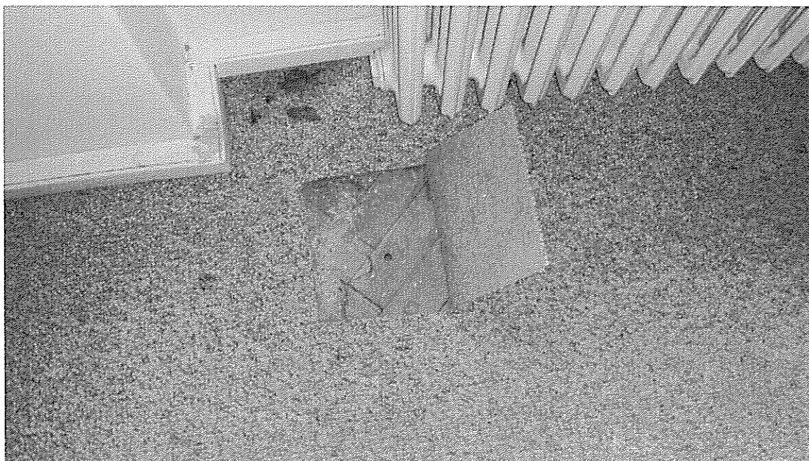
Sonda S3 – sonda do podlahy v místnosti 109 u obvodové zdi
