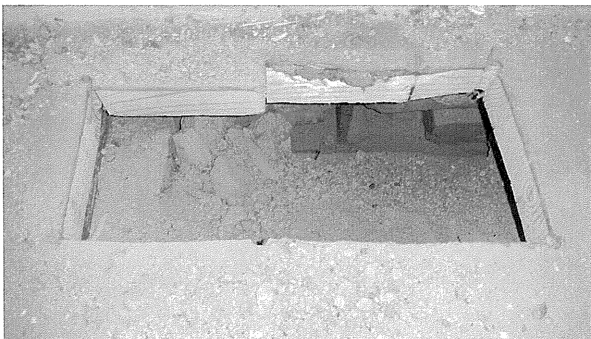
Sonda S1b – vybrání násypu a záklopu v sondě do podlahy v místnosti 267 nad místností 165
