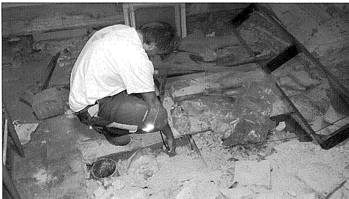
Sonda S7 – průzkum původní sondy do konstrukce podlahy půdy nad kancelářemi odboru správy majetku
