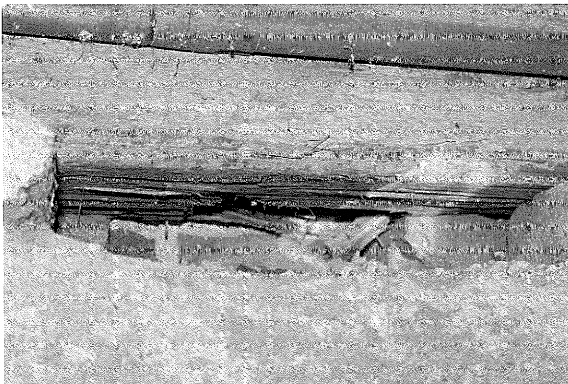
Rozpadající se pozednice
