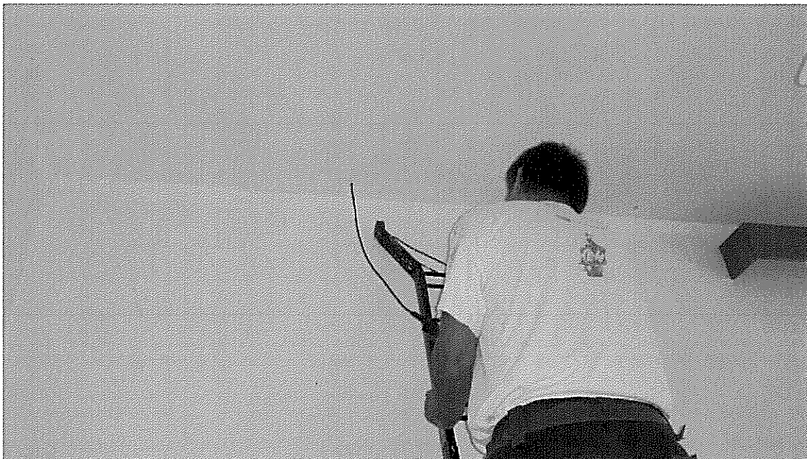
Sonda S2 – endoskopický průzkum dvou vrtaných sond do sádkartonového podhledu v místnosti 151
