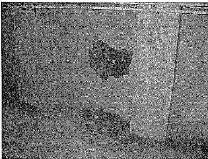
Vzorek č. 7 byl odebrán z obvodové západní zdi v bývalém krytu CO. Povrch je tvořen rozrušenou MVC omítkou. Ve struktuře zdiva byly objeveny kusy nevyhašeného vápna.
