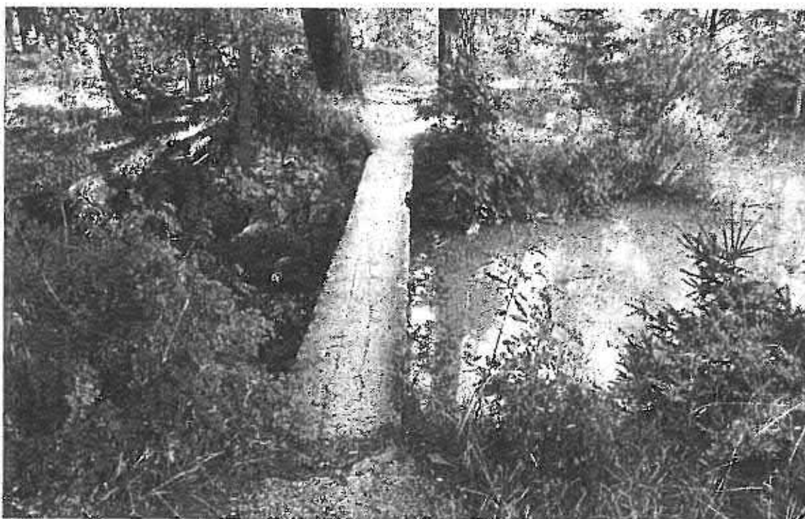
Poškození pravobřežního zdiva koryta od přelivu
