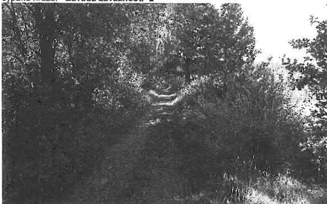
Pohled na hráz od levého závazání
