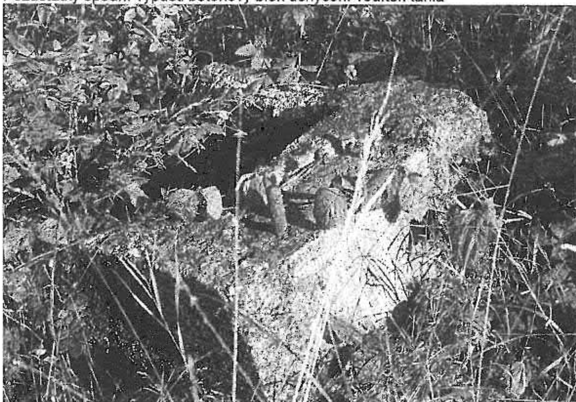
Pozůstatky spodní výpusti betonový blok uchycení vodítek táhla
