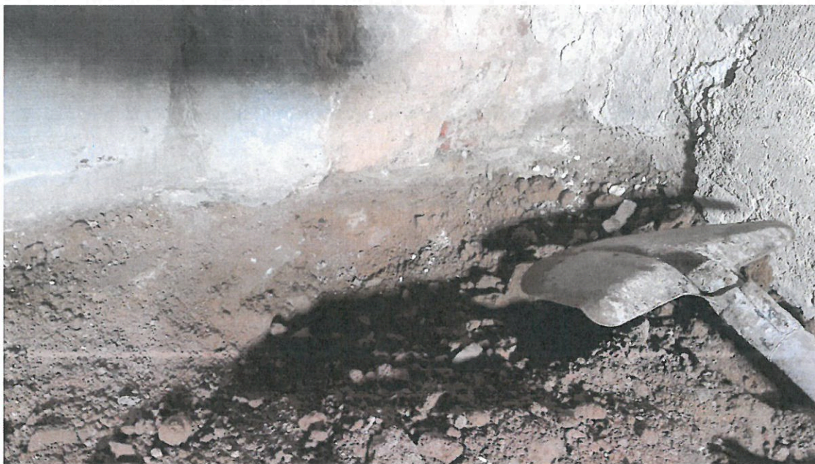
Obr.3 – Kopaná sonda u dělicí přičky – úroveň lopaty je úroveň založení
